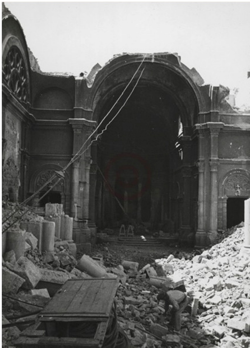
Vista del interior de l'església de Santa Mònica durant el seu enderroc el 1936. . Font Arxiu Fotogràfic de Barcelona ( http://www.bcn.cat/arxiu/fotografic/ )
